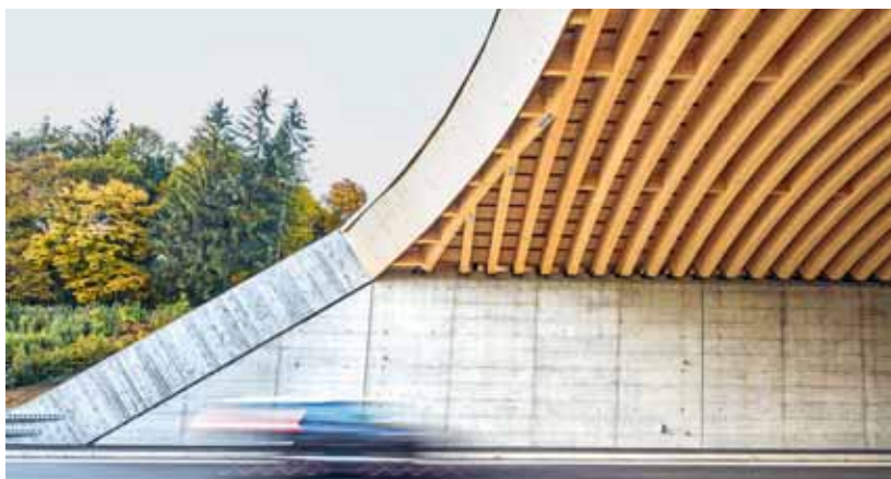
Die erste Schweizer Wildtierbrücke aus Holz führt zwischen Gränichen und Suhr über die Autobahn A1. Quelle: Timbatec, Nils Sandmeier
